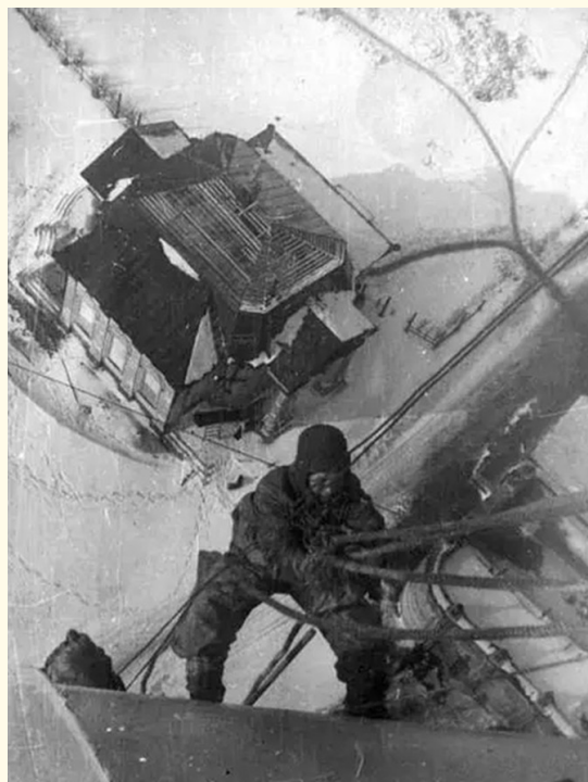
Верхолаз М.И. Шестаков выполняет маскировочные работы на шпиле Петропавловского собора, 1942 г.
